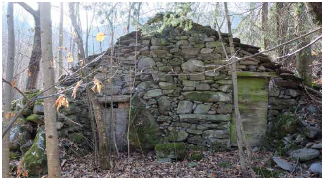
"Bédülèro": casello del latte alimentato dal fiüm.
