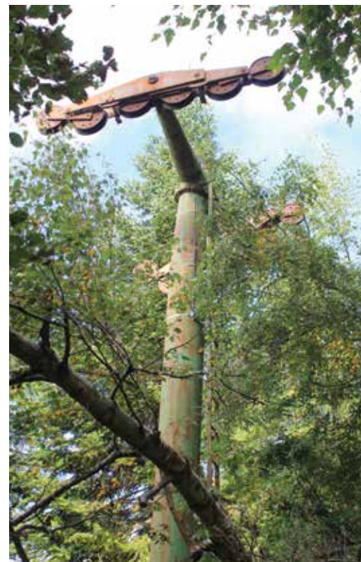
Impianti in abbandono.
