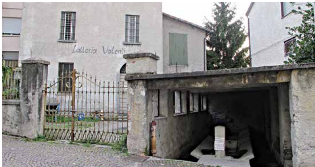
Latteria e lavatoio coperto alimentati dalla roggia comunale. Foto Enea Gusmeroli.
